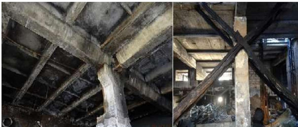
Рис. 5. Поврежденные железобетонные конструкции после пожара.
