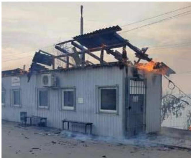
Рис. 3. Деформация металлической конструкции в результате пожара
